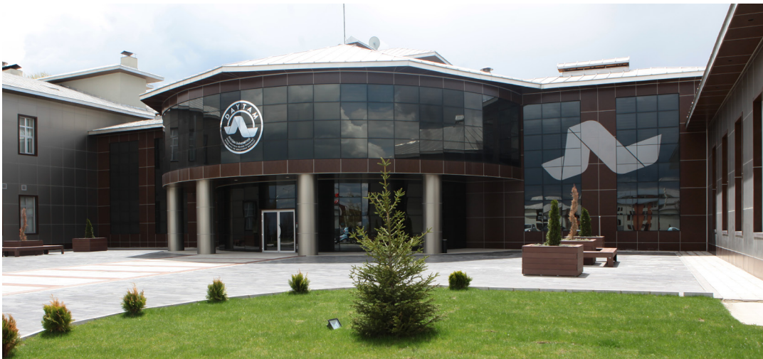
Merkezi Araştırma Laboratuvar Binası
