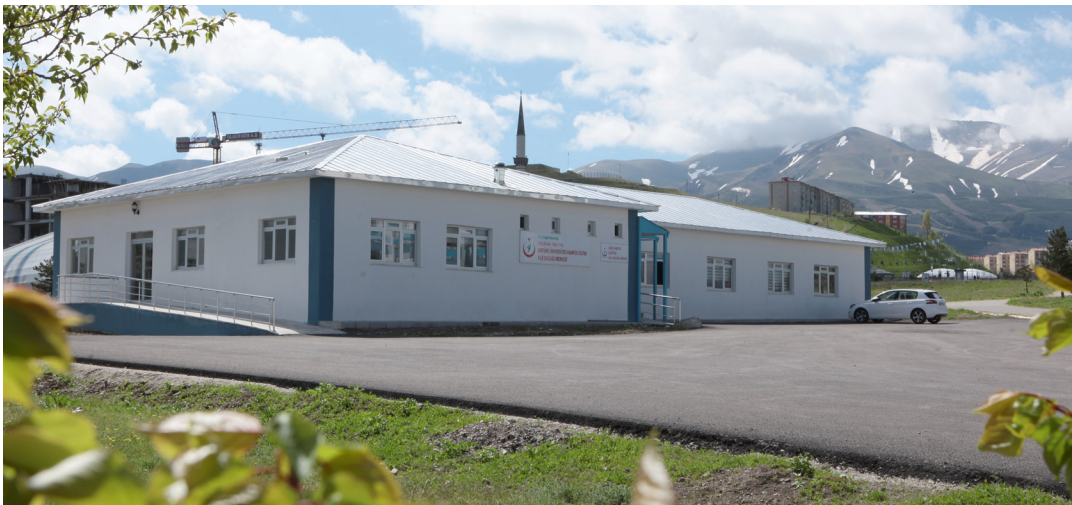
Aile Sağlık Merkezi Binası
