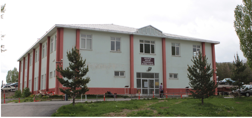
Erzurum Meslek Yüksekokulu Ek Binası
