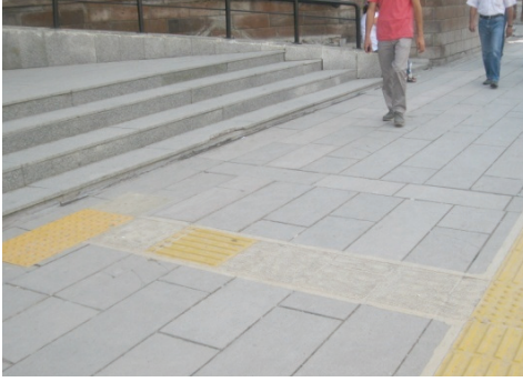
Klavuz çizgilerinin oluşturan malzemelerin zamanla sökülmesi sonucu oluşan durum
