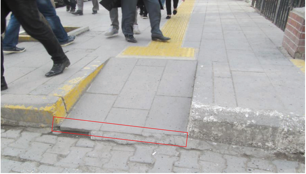
Rampa başlangıcındaki engeller.
