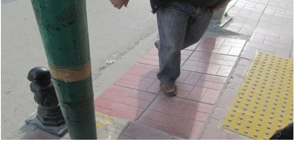
Yanlış malzeme kullanımından dolayı oluşan kaygan rampalar.
