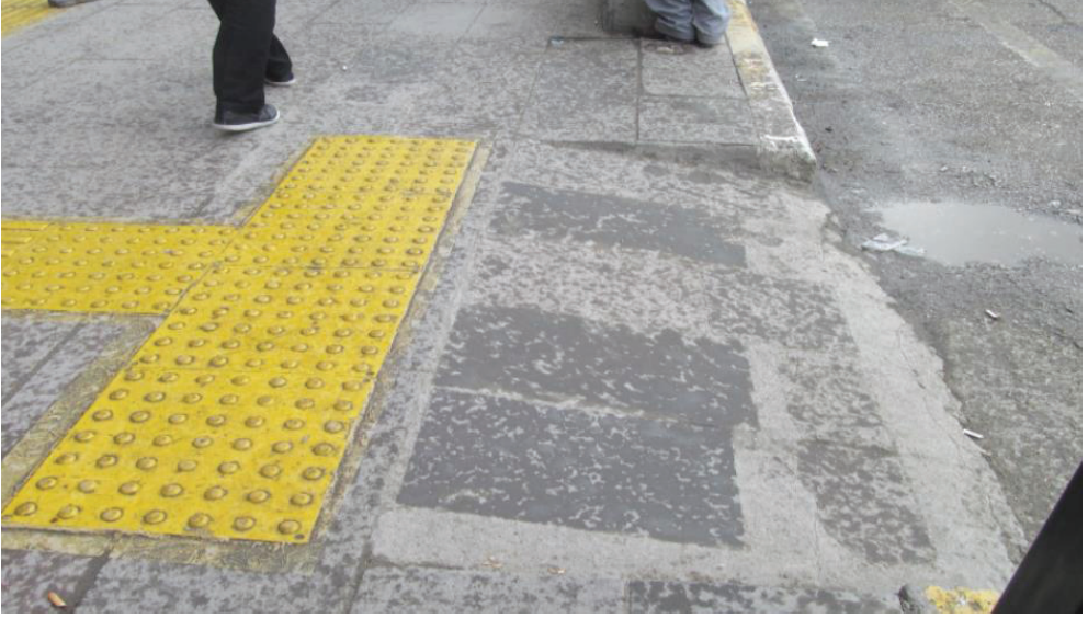
Kabartma yüzeyleri var; fakat bu yüzeyler yağış olduğunda kayganlaşıyor.
