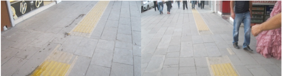
Klavuz çizgilerinin eksik döşenmesi
