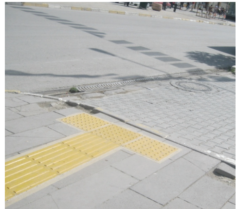
Klavuz çizgilerinin köşelerde aniden bitmesi ve çarpmaya veya düşmeye yol açması
