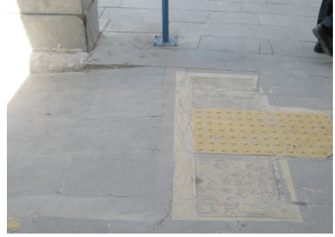
Klavuz çizgilerinin oluşturan malzemelerin zamanla sökülmesi sonucu oluşan durum
