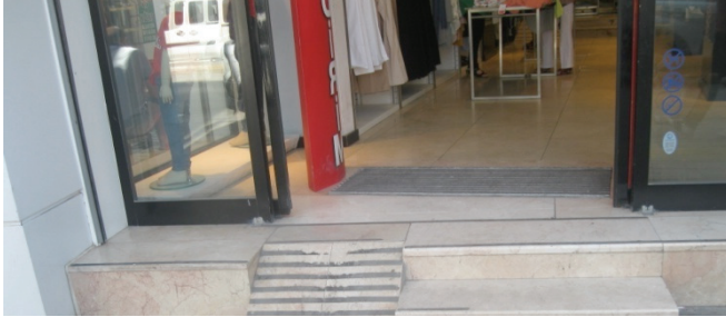
Mağaza girişlerinde kullanılmayan rampa ve merdivenler olması
