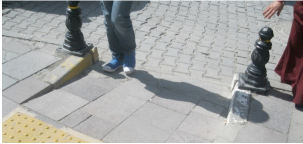
Rampa eğimlerinin doğru olmaması ve rampada kayan malzeme kullanılması
