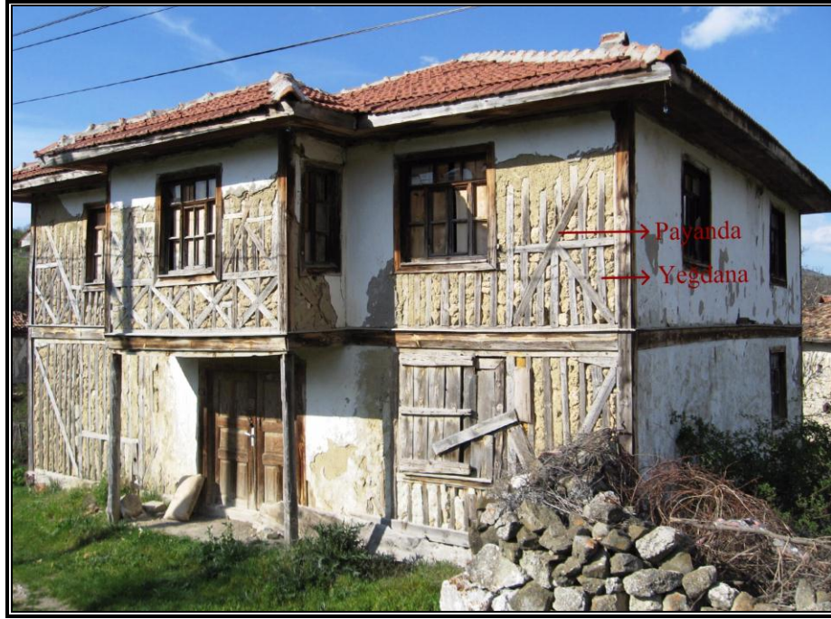
Fotoğraf 2.38. Sahada Köy Meskenlerini Karakterize Eden Mesken Tipi Ahşap Karkastır.
