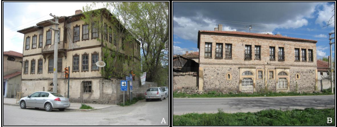
Fotoğraf 2.45. Çerkeş Evleri Genellikle Ahşap Karkas Yapı Tarzında (A) Yapılmışken Ahmet Sopacı Evi Kesme Taş, Tuğla ve Horasan Harcıyla Yapılmış (B) Meskenlere İçerde Tek Örnektir.
