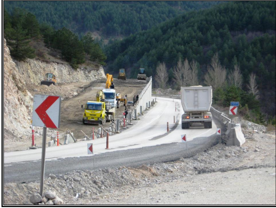
Fotoğraf 3.34. İsmetpaşa Boğazındaki Duple Yol Çalışmalarından Bir Görünüm.
