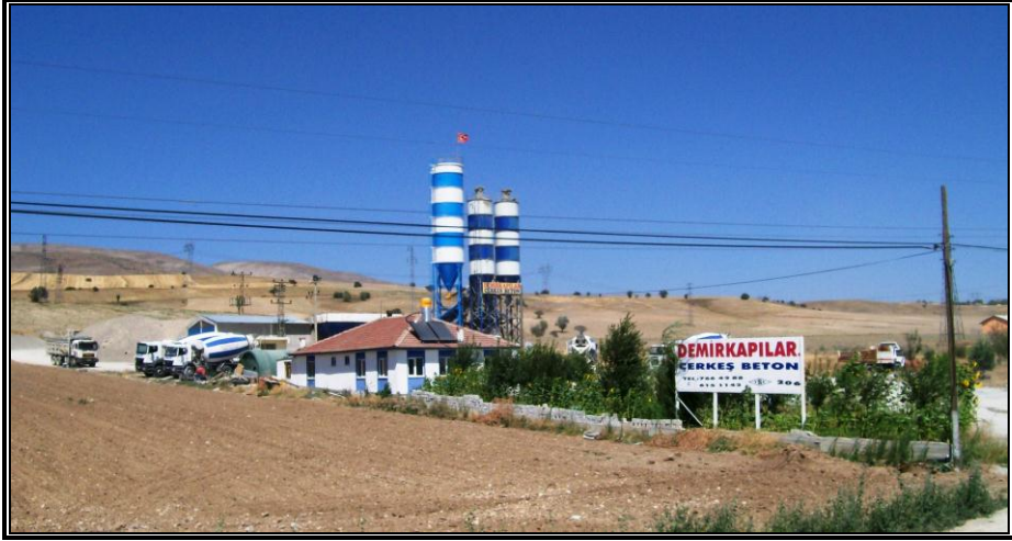
Fotoğraf 3.28. Demirkapılar Çerkeş Beton Hazır Beton Tesislerinden Bir Görünüm.
