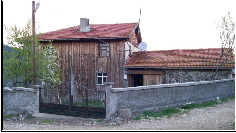
Fotoğraf 2.40. Bazı Meskenlerde Karkas Örgü Sisteminin Dışı Çamurla Sıvanmak Yerine Ağaç Malzeme İle Kaplandığı Görülmektedir.
