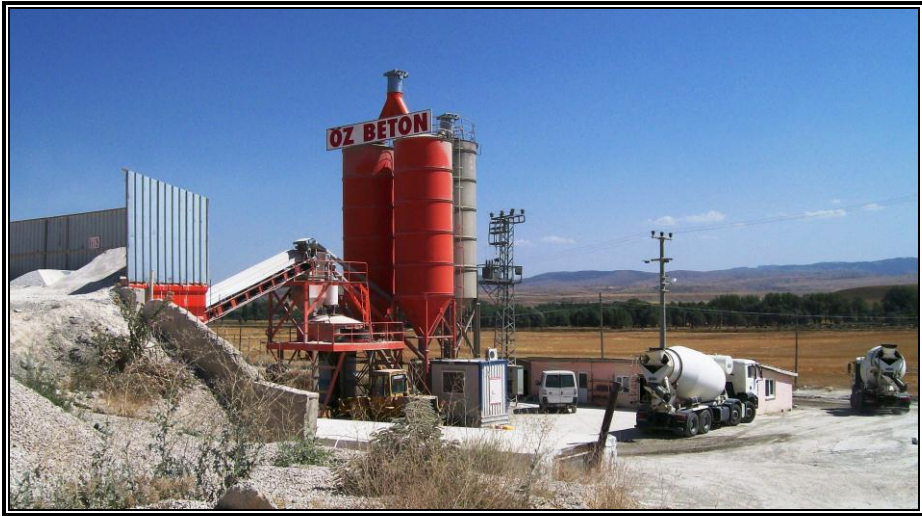
Fotoğraf 3.29. Öz Beton Hazır Beton Tesislerinden Bir Görünüm.
