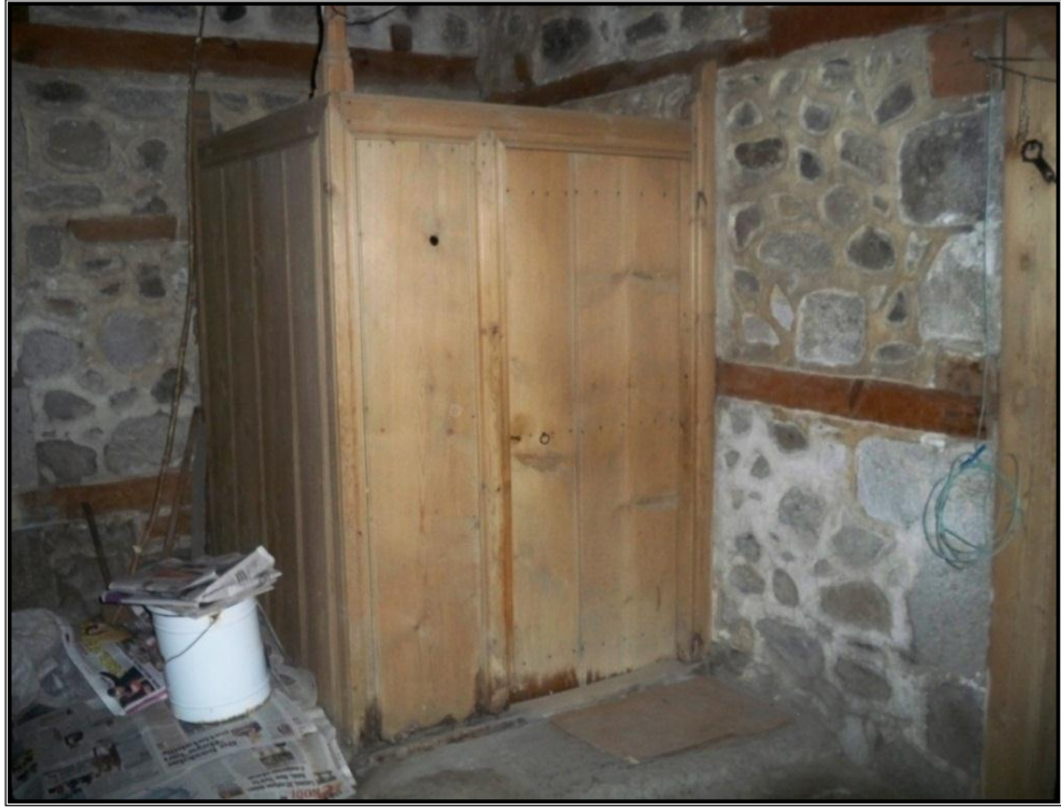
Fotoğraf 2.26: Somunoğlu Evi'nde Avlunun Uzak Köşesine İnşa Edilmiş Olan Hela.
