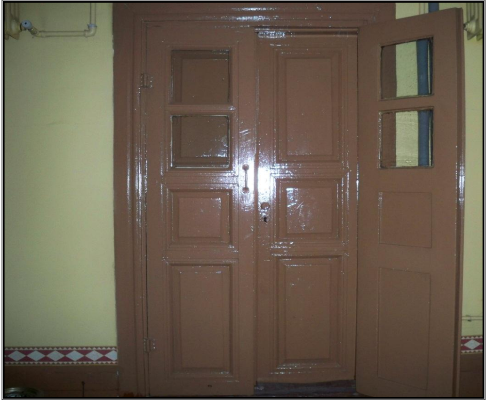
Fotoğraf 2.33: Kullebi Akif Ağa Konağı'nda Çift Katlı ve Çift Kanatlı Kapı Örneği.
