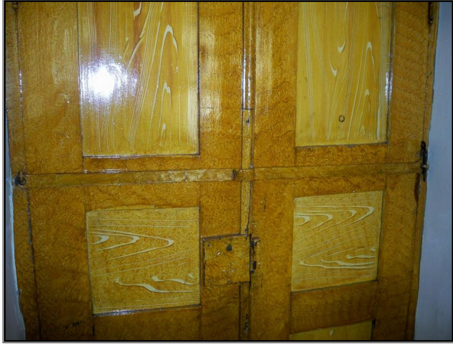
Fotoğraf 2.24: Kullebi Akif Ağa Evi'ndeki Oda Kapısının İçeriden Kilitlenme Sistemi.
