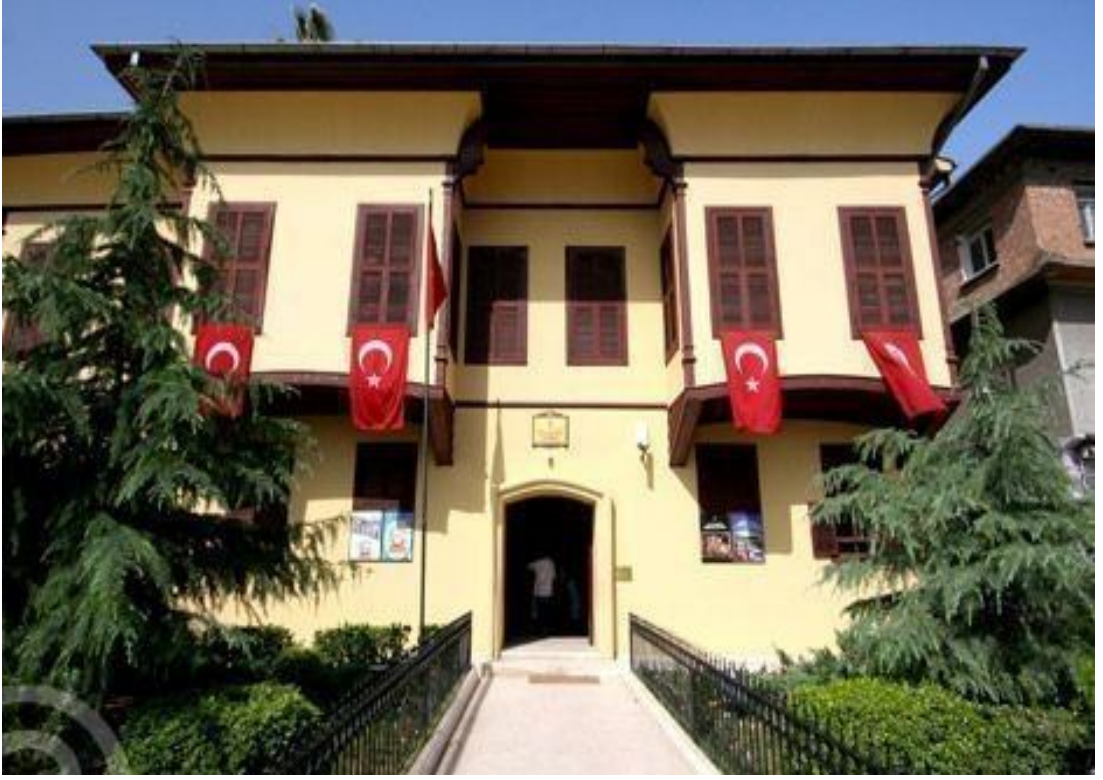
Ek 4. Suphi Paşa Konağı'nın Günümüzdeki Restore Edilmiş Hali
