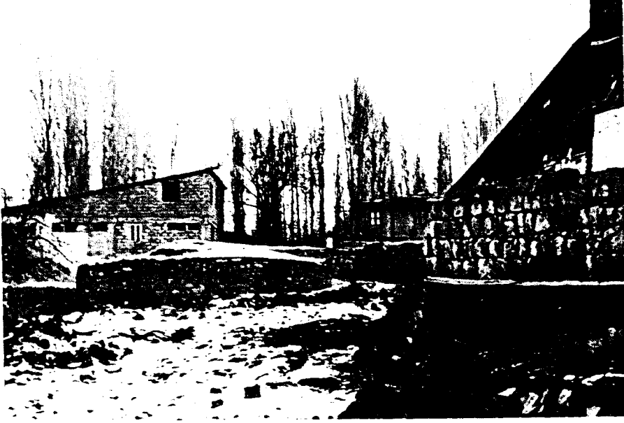
FOTOĞRAF 19. Hınıs'ta eski tip konutlarda taş yapı malzemesinin kabaca kullanımı.
